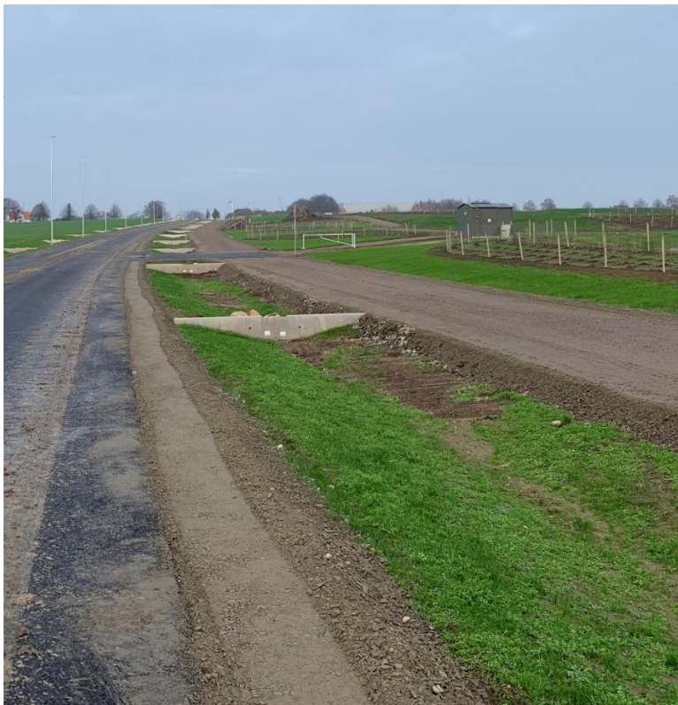
Figur 17. Svackdike med "trappning" med betongkonstruktion.
