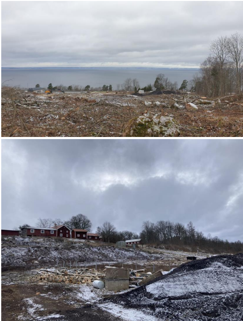
Figur 3. Foton tagna från planområdet vid platsbesök i början av februari. I fotonas ses att visst anläggningsarbete har börjat.
