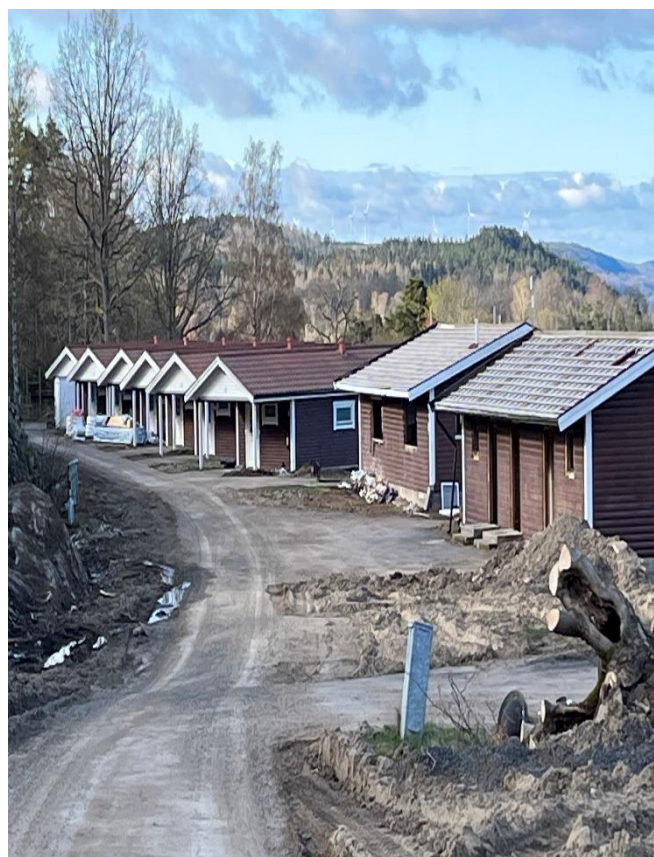
Bild 9. Bilden visar befintliga fritidsstugor som rustas upp samt två av befintliga byggnader som håller på att rivas.
